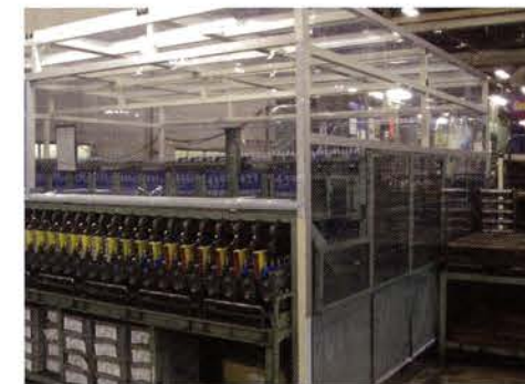
ビニールブース (スチールフレーム)
