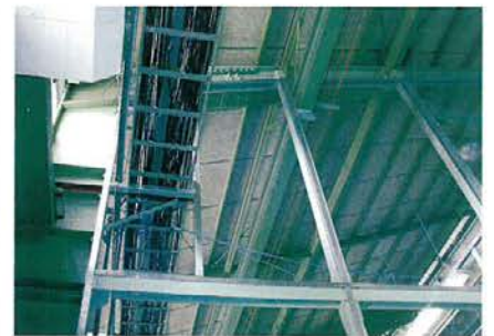
障害物間仕切り工事
