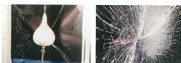
フィルム未施工
