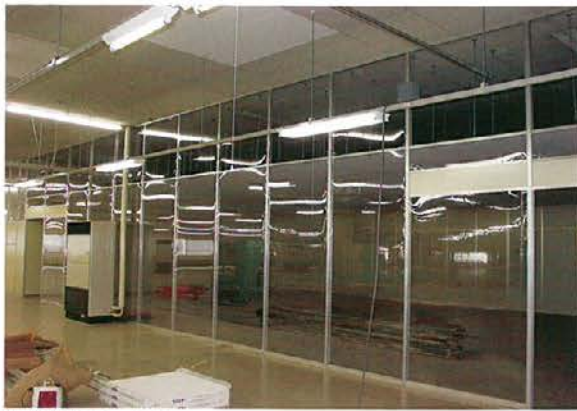
間仕切りフェンス
