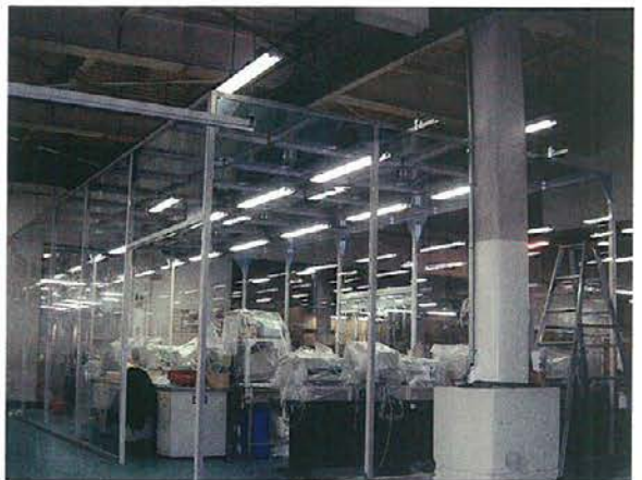
作業場クリーンブース
