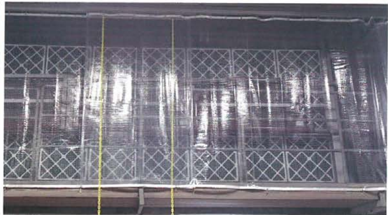
糸入り防災静電透明0.5mm 1cmます目(ST-6000)シート使用
