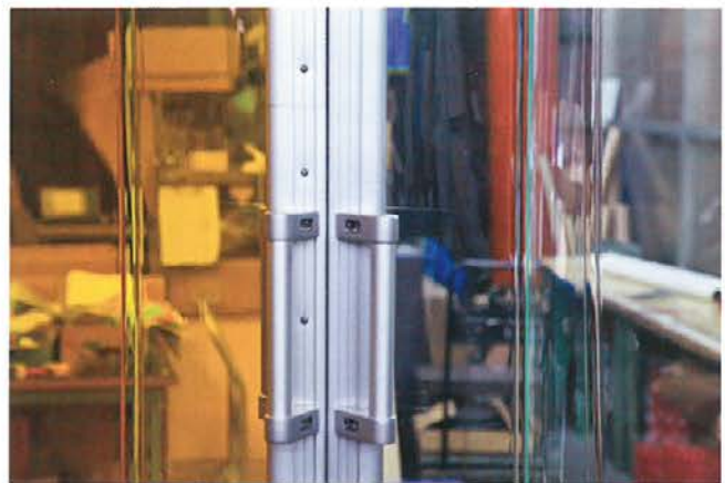
ジョイント部分 (左側 ジョイントタイプ) 右側 1本物タイプ
